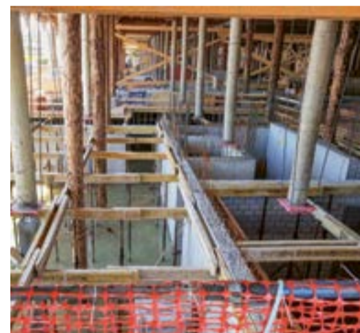
Das Kornhaus wurde während des Umbaus komplett ausgehöhlt. Rund 80 Baumstämme übernahmen in der ersten Phase der Sanierung die Gebäudelast.
